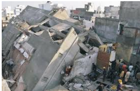
Figura 67 - Local do desabamento
